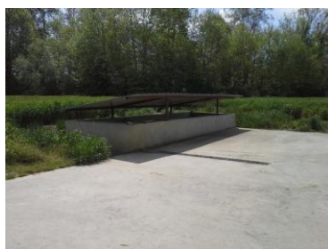
Aire de lavage équipée d'un « phytobac » pour traiter les eaux de lavage du pulvérisateur
